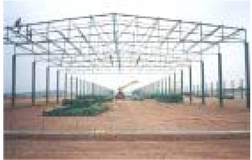
Estruturas metálicas de um galpão industrial
